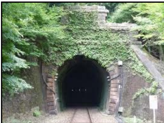
明治 33 年京都一園部間で開通した京都鉄道の保津峡トンネル。 建設には大変な苦勞があった。現在は、トロッコ列車が使用している。
